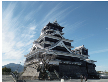
熊本城 (写真提供：熊本城総合事務所)
