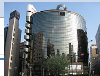
ホールディングス 本社ビル全景
